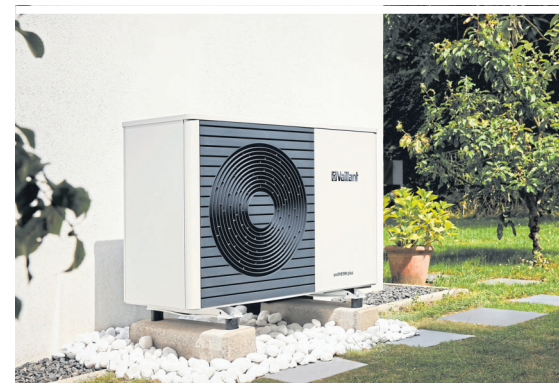
Wärmepumpe nicht auch schallharten Oberflächen wie Beton und Asphalt aufstellen
